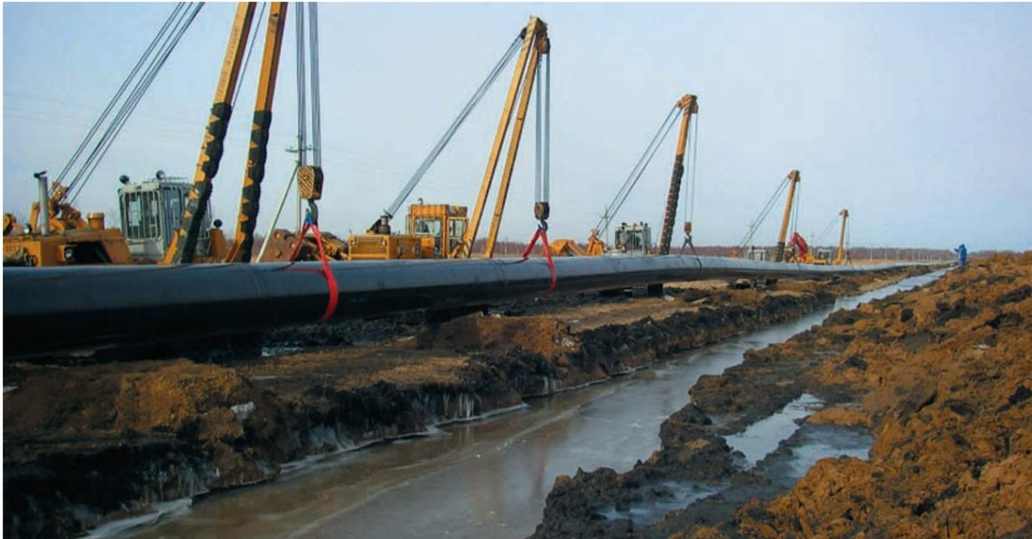
Траншея, куда укладывалась труба, достигала 9 метров в ширину и при этом всегда была заполнена водой
